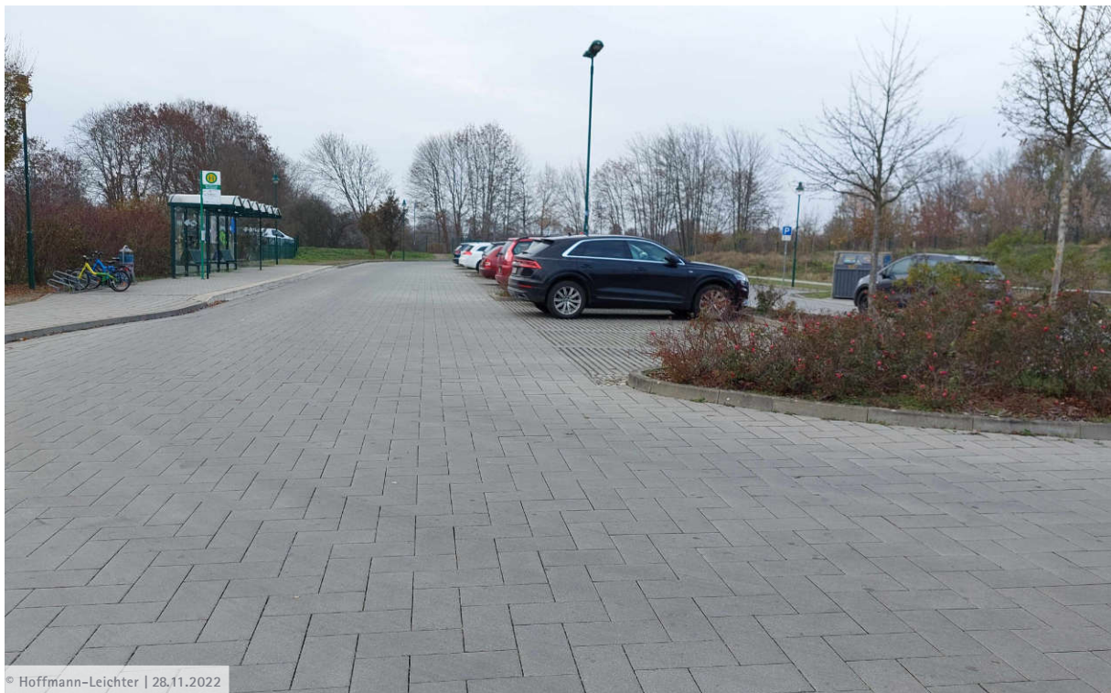
Bild 4 Wendehammer an der Grundschule | Blickrichtung Nordwesten
